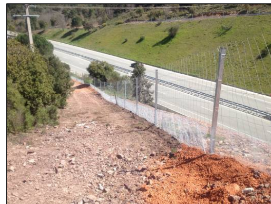
Clôture grande faune doublée à la base d'une clôture petite faune (SEGED, avril 2012)
