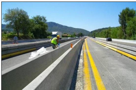
Aménagement de dispositifs de retenue en béton sur un chantier (SEGED, juillet 2010)
